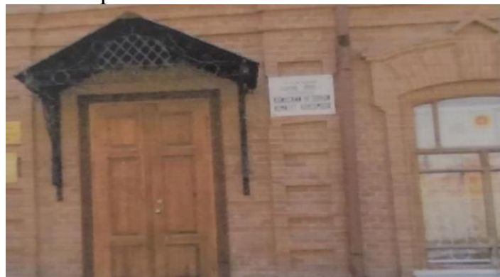
Фото 3. Фрагмент фасада входа в здание
