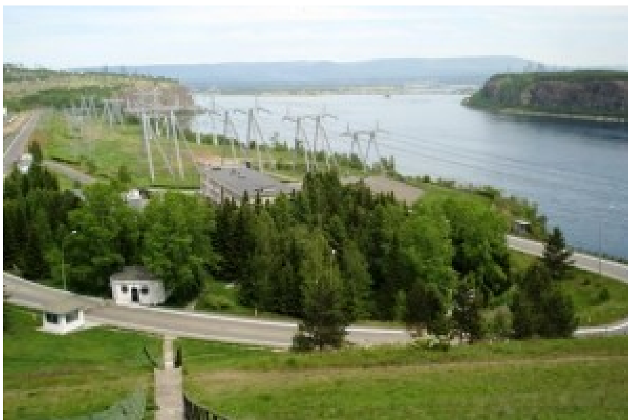
Братская ГЭС. Подстанция.
